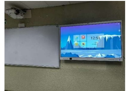
Pantallas instaladas en aulas
