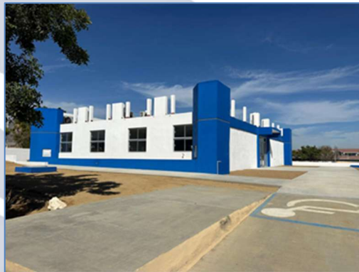
Vista costado izquierdo Edificio "H"
